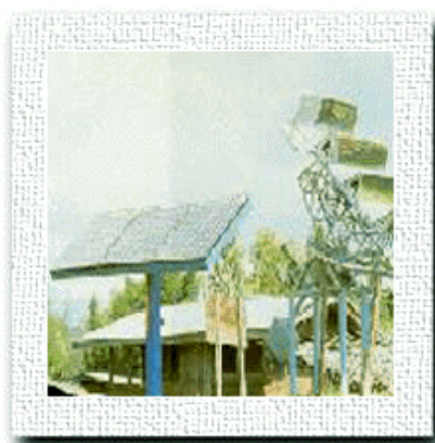
การใช้เซลล์แสงอาทิตย์ กับสถานีทวนสัญญาณ โทรศัพท์ที่ติดตั้งบนภูเขาสูง
